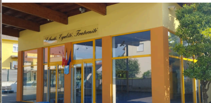
Ravalement de façade de l'école élémentaire
