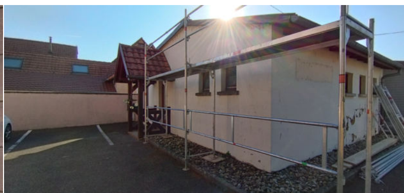
Ravalement de façade de la salle de danse
