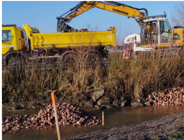
Renforcement et reprofilage des berges de la SONDERAU
